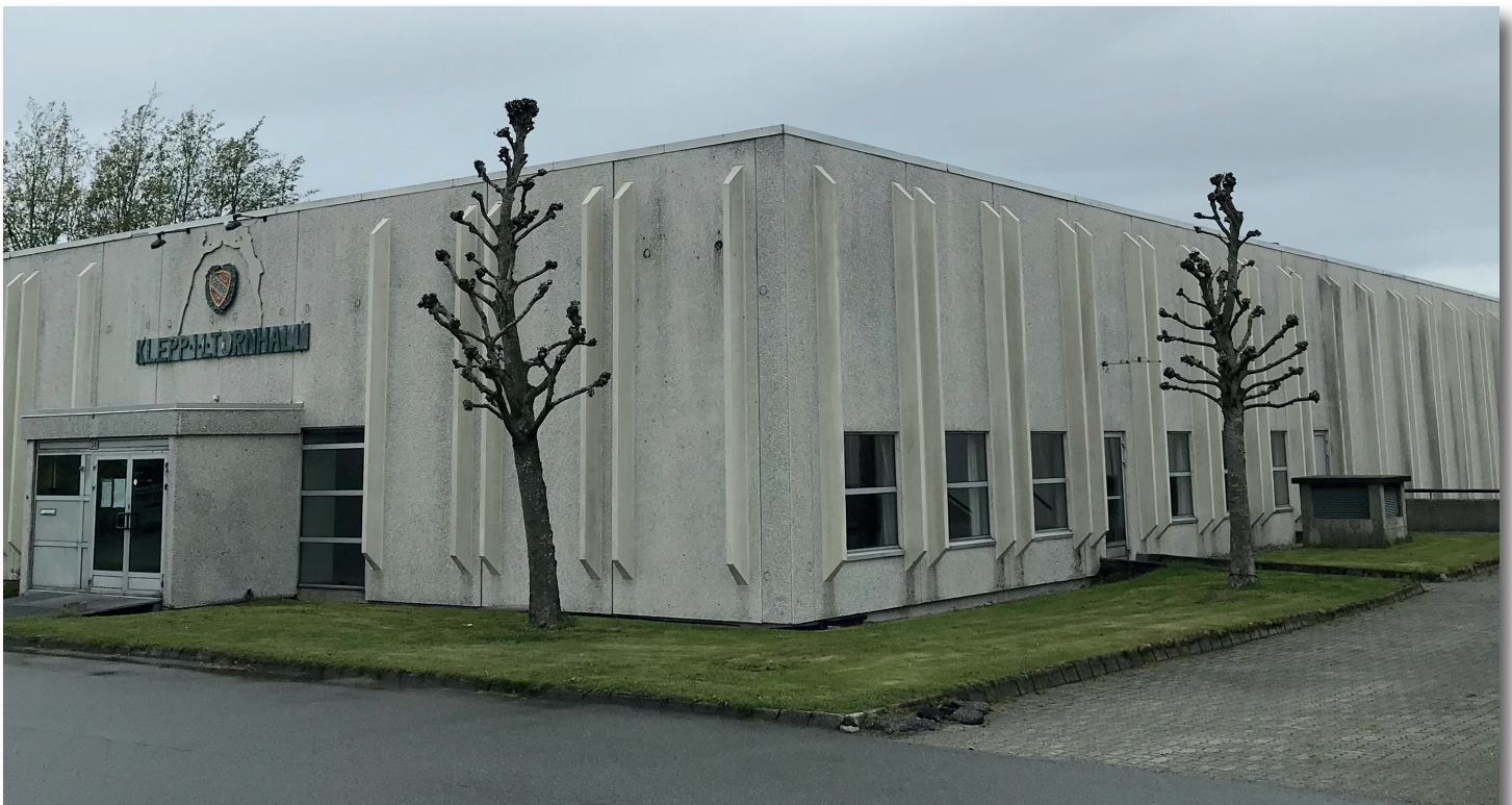
Dagens Turnhall, ferdigstilt i 1982.
